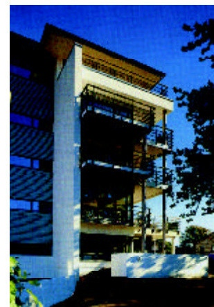
Altaner inden for det supplerende byggefelt
